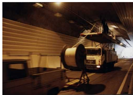
取付工事の様子
