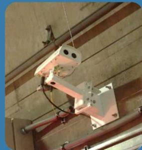
赤外線カメラと可視光カメラの双方を搭載しています。撮影した赤外線カメラの映像を自動解析し、火災検知を行ないます。さらに、火災が発生する前の停止車両、熱、煙などを検知することができます。これにより、従来方式と同等、あるいはより迅速な非常事態の把握が可能です。可視光カメラは一般的な HD カメラと同等の性能を持ち、CCTV の代替として使用することができます。
