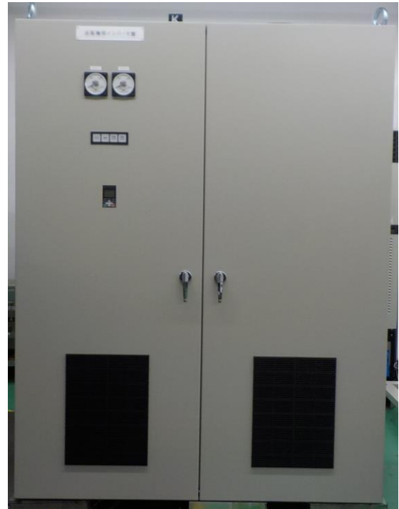
送風機用インバータ換気動力盤
