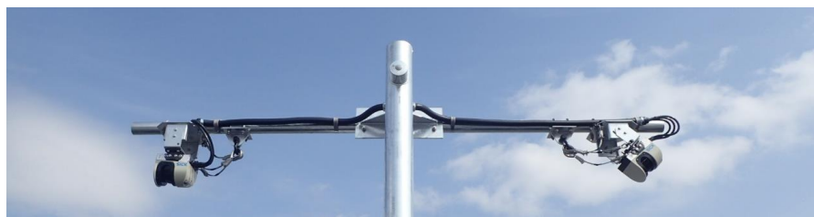
レーザ式 TC 計 設置
